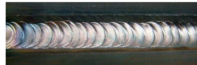
Сварной шов трубы без видимых дефектов
